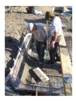
Début du coulage, les premiers essais permettent de déterminer le bon dosage d'eau pour une consistance optimale. L'enduit se fait de bas en haut. L'arrière du grillage à été coffré, si la place le permet on peut aussi enduire à deux personnes en « miroir » une à l'intérieur, une à l'extérieur.
