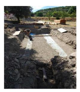
Mise à niveau en couvrant le drain de cailloux, galets ou graviers drainant
