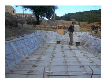
Réalisation et ligature du premier quadrillage. On pose des cales de 2 à 3 cm de haut pour sur-élever toute la structure
