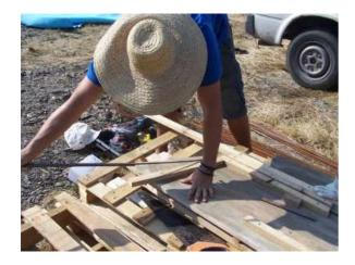
Pliage des fers à béton de 6mm pour former le premier maillage de la structure (40 X 40 cm). Une table de pliage auto-construite permet d'être précis et rapide.
