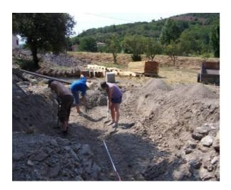
Après la pelle mécanique, le terrassement manuel permet d'assurer la planéité du sol avec une légère pente dans le sens de l'écoulement
